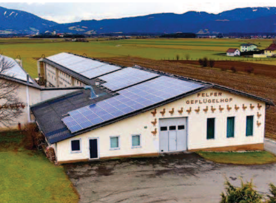
PV-Anlage auf einer Geflügelfarm in Rattenberg, Tirol
